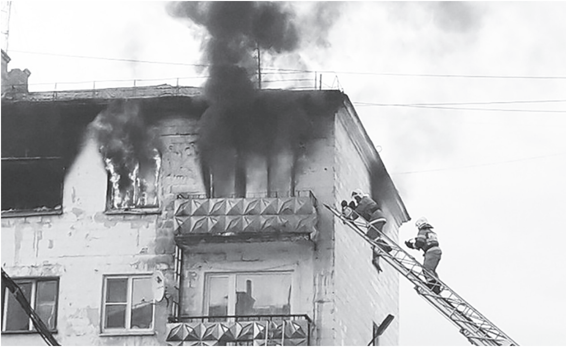
2017 год. Пожар в квартире по ул. Усошина случился неожиданно и огонь быстро распространился
