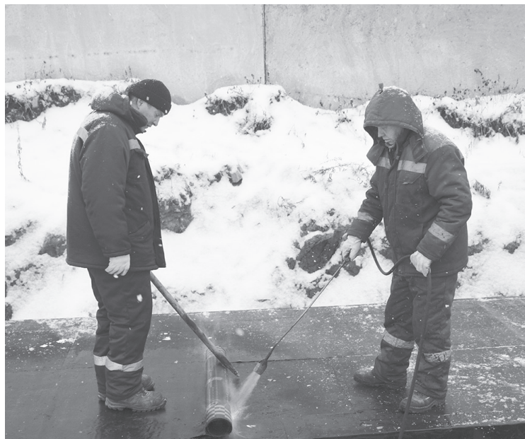
На объекте работают сварщики, монтажники, слесари...
