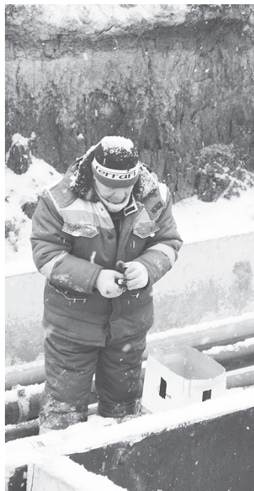
Чтобы снизить вероятность повреждений трубопровода, его увели под землю, смонтировав надёжный бетонный канал
