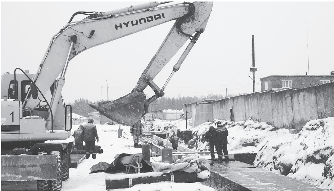
Сегодня на объекте идёт процесс многоступенчатой гидроизоляции. Следующий, завершающий шаг — засыпка траншеи. В выполнении работ задействовано от 25 до 30 специалистов
