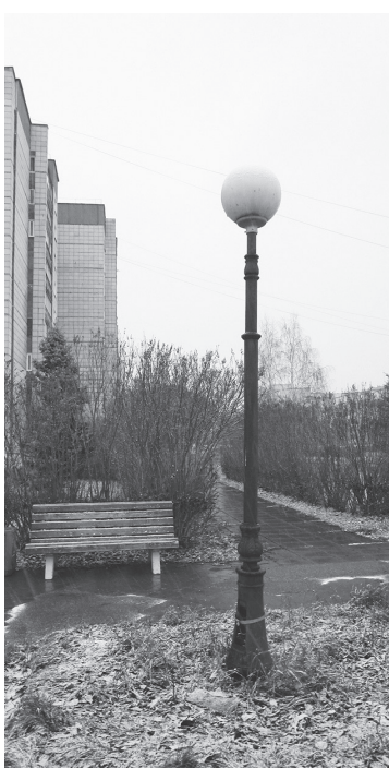
И здесь столб накренился... а может и сразу был так установлен...
