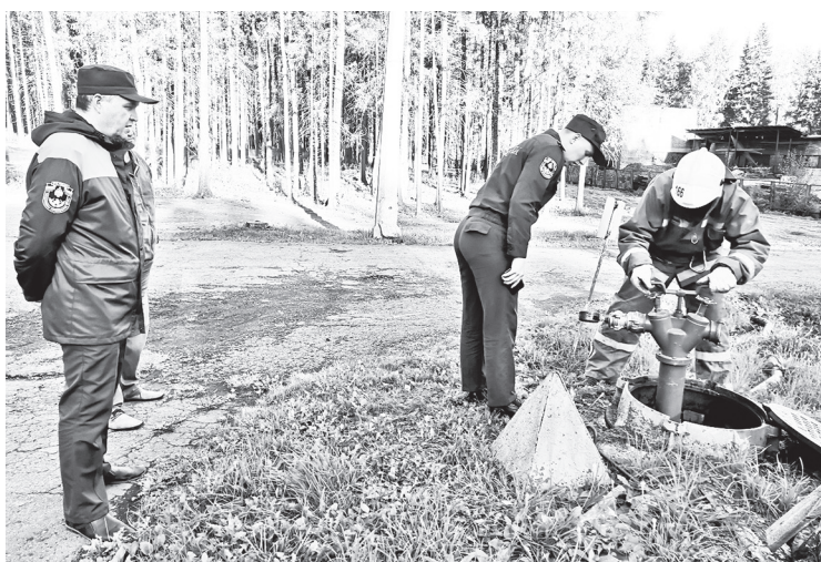
Сотрудники МЧС во время проверки источников наружного противопожарного водоснабжения
