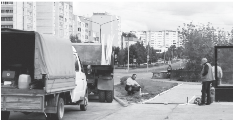
Благоустройство подступов к автобусной остановке, ул. Ленина, д. 101
