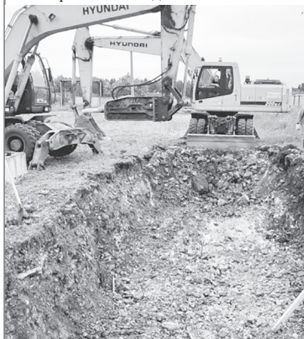
Посёлок Ёлкино, на одном из участков восстанавливаемой теплотрассы
