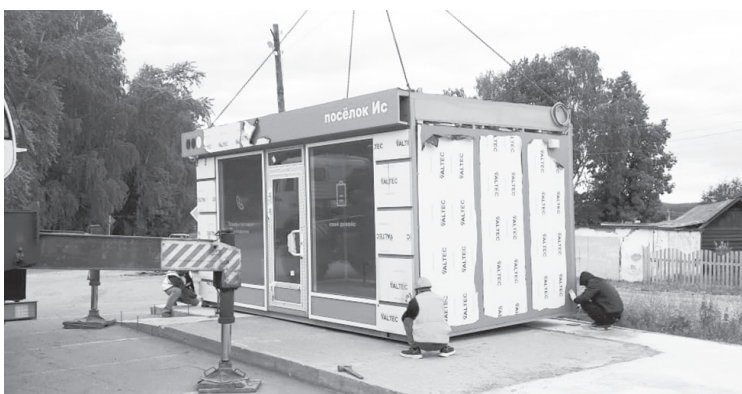
Тёплая остановка установлена ещё и в посёлке Ис
