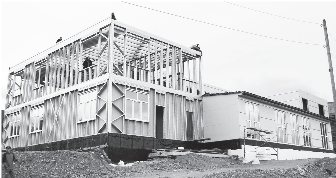
Строители работают по 12 часов, чтобы успеть построить школу к 1 сентября
