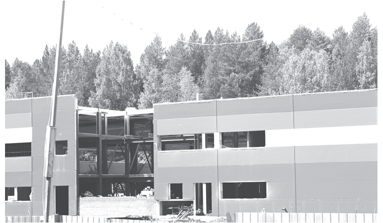
Так выглядит стройка сейчас
