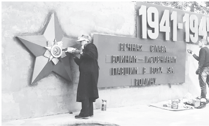
Сейчас монумент уже покрашен, установлены светильники для подсветки, началось бетонирование дорожек
