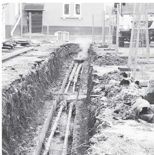
Замена труб водоснабжения
