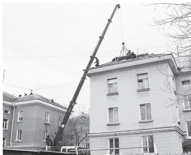
С подъёмным краном работа идёт быстрее
