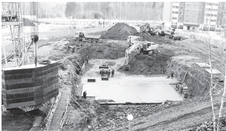
«Стройка оборонного значения»
