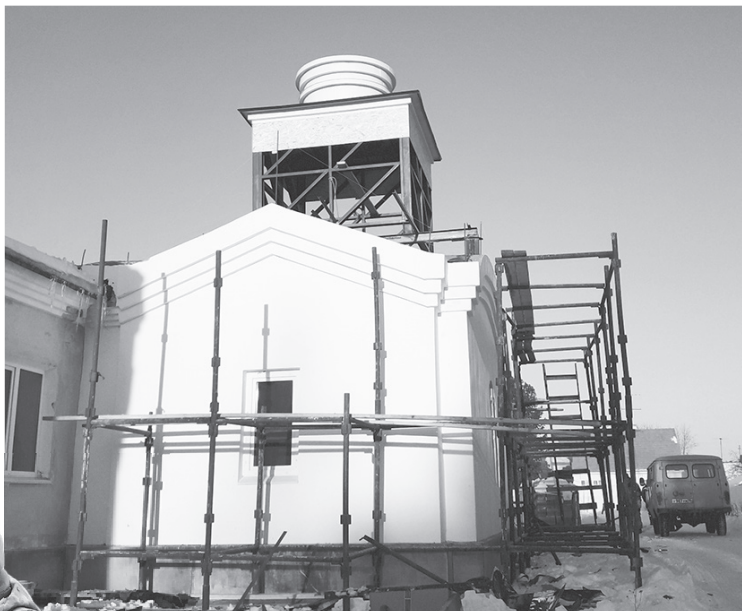
Монтаж конструкции по возведению нового купола в восточной части храма
