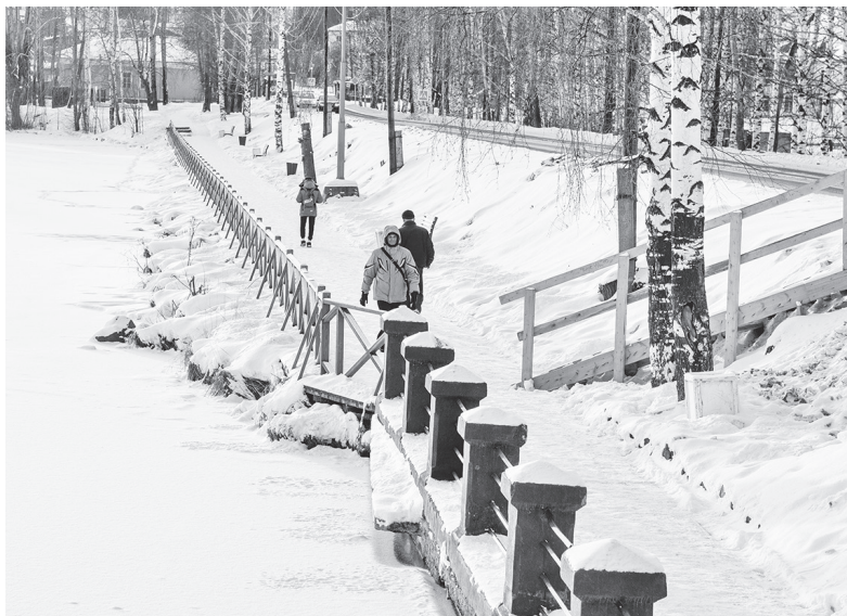
Один из участков обновлённой набережной Нижнетуринского пруда. Долго ли прослужат людям эти деревянные конструкции?
