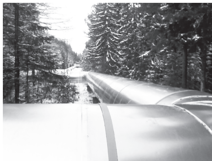
Изоляция этого трубопровода выполнена отделением предприятия «РТС» из г. Лесного
