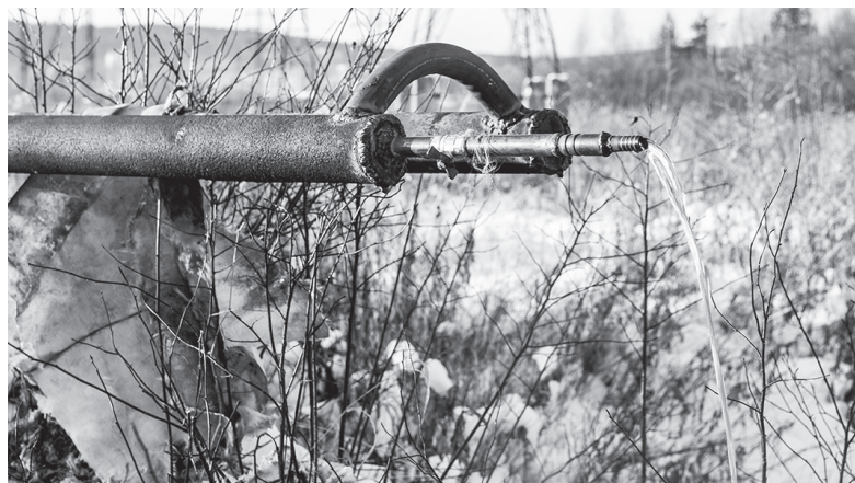
Перемычка, заглушка, слив — вот так закончили ремонт трубопровода работники ГЭСКО, пройдя всего пятую часть аварийной трассы
