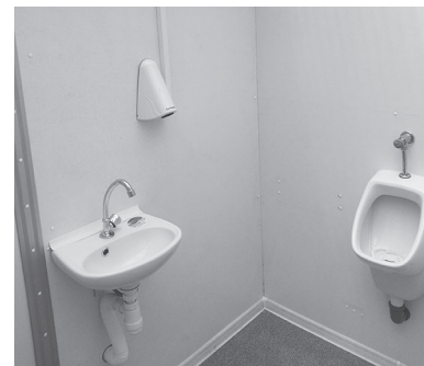
Оптимальное внутреннее обустройство туалетной кабинки, ж/д вокзал, г. Москва
