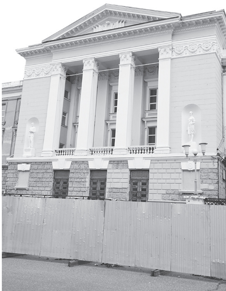
СКДЦ «Современник» после ремонта потребуются новая электроподстанция, но пока не готов даже проект на неё
