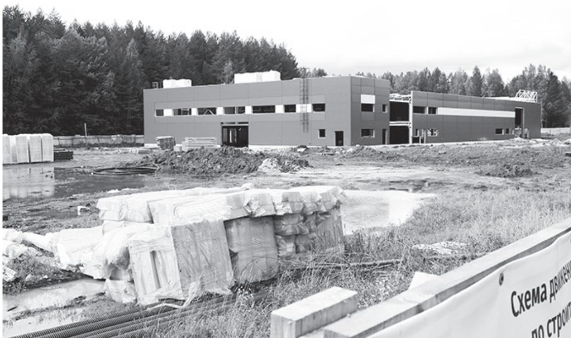
Нового подрядчика на строительство «Ледового дворца» обещают найти к октябрю
