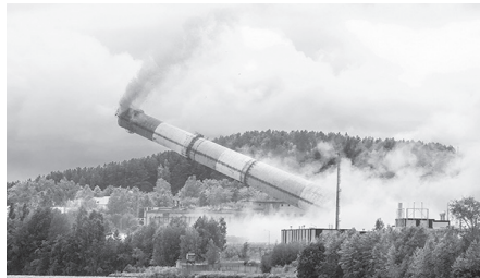
Последняя из трёх труб, подлежащих демонтажу, легла на землю, в последок окутав окрестности дымком...
