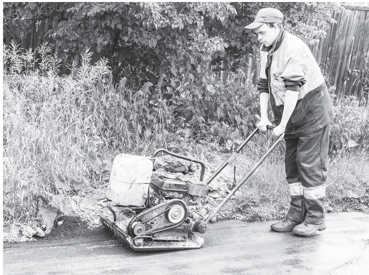
Работы на ул. Чапаева
