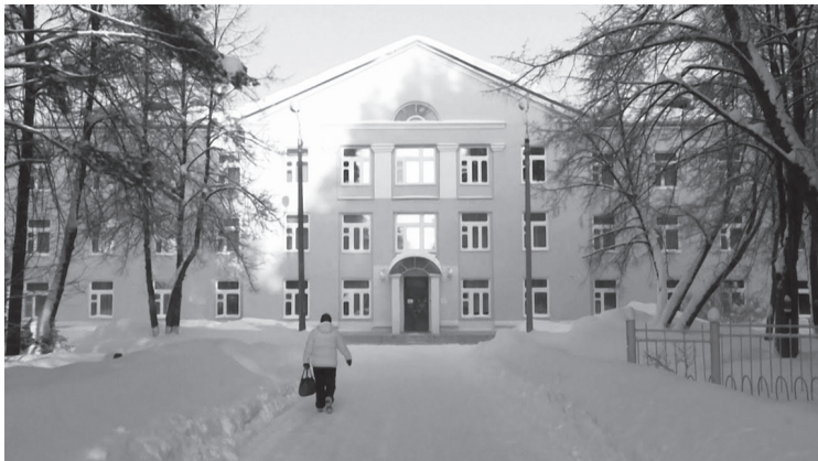
Главный вход в здание реабилитационного центра комбината «Электрохимприбор». Фото из сети Интернет
