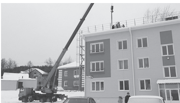
Строители устанавливают усиление вентиляции дома
