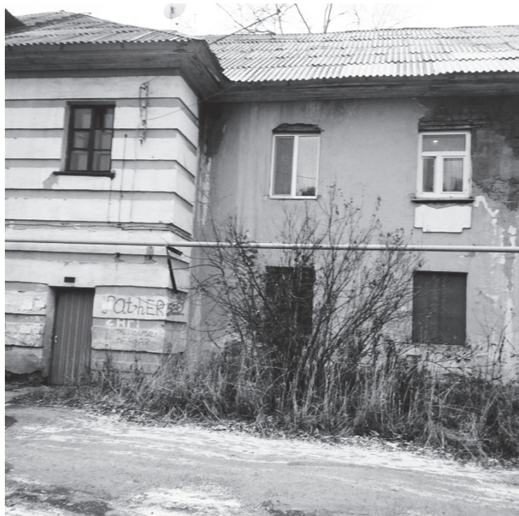
«Поражающий воображение» фасад дома с муниципальным жильём
