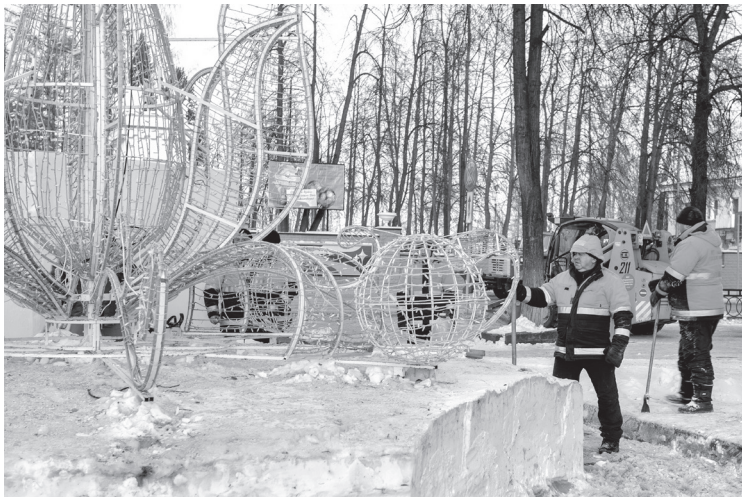
Завершение работ в новом ледовом городке г. Лесного
