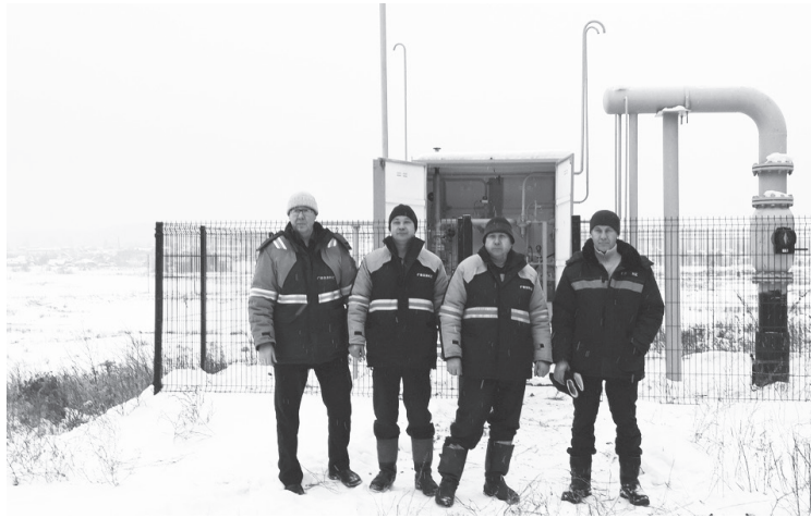
Бригада сотрудников АО «ГАЗЭКС», снабжающих посёлок газом
