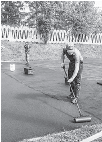
На стадионе школы № 76 идут ремонтные работы
