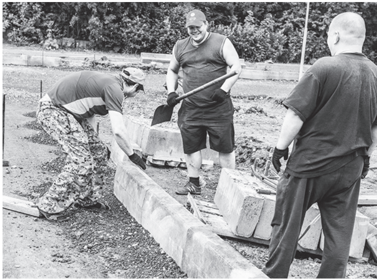
Дорожные работы на перекрёстке Энгельса — Победы
