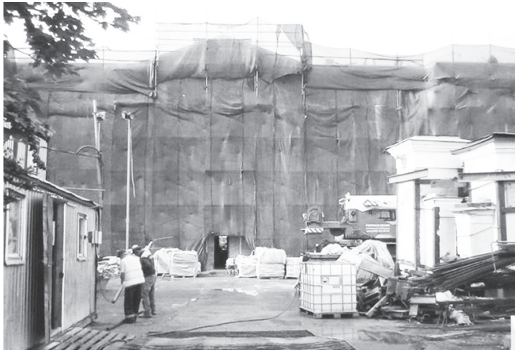
Так усадьба выглядит в процессе реконструкции под Президентский центр Б.Н. Ельцина
