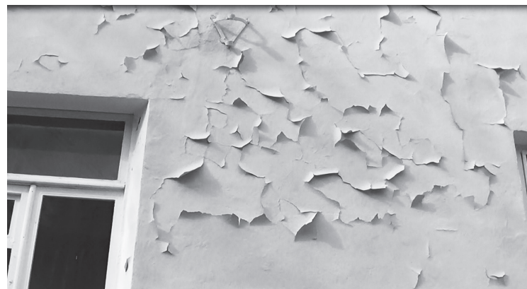
Этот дом отремонтировали в 2016 году. ФОТО АВТОРА
