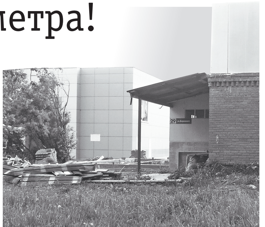
Стройка полным ходом! ФОТО АВТОРА
