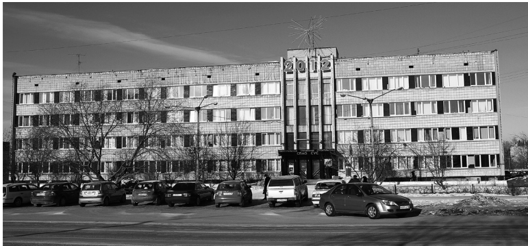
Здание администрации Лесного.
